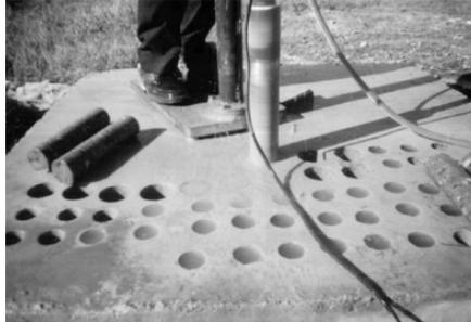
**Figura 1. Extracción de núcleos de concreto.**
