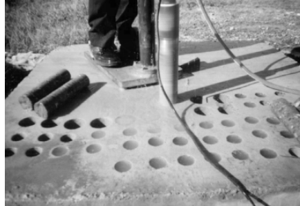
Figura 1. Extracción de núcleos de concreto.
