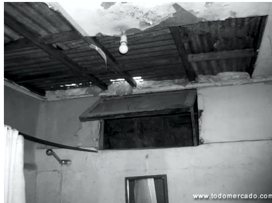
Figura 5. Impermeabilización inadecuada.
